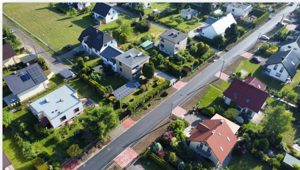
Przebudowana ulica Zawila w Czechowicach-Dziedzicach
