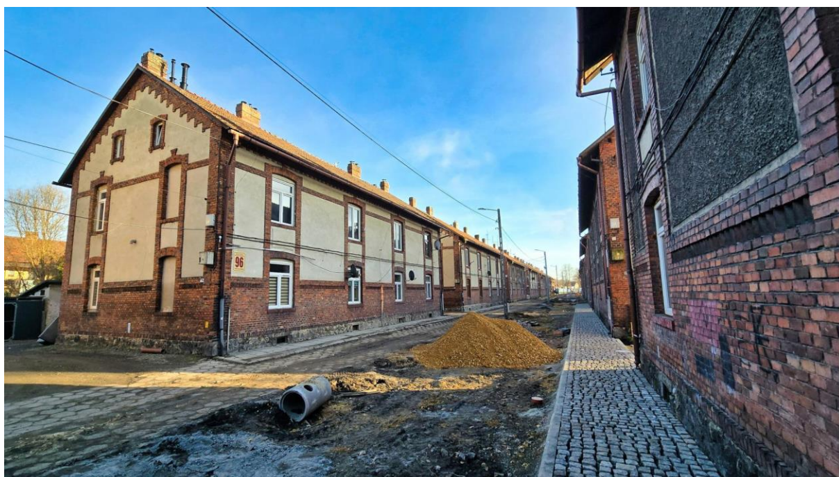
Fot. Przebudowa ulicy Węglowej bocznej w Czechowicach-Dziedzicach.
