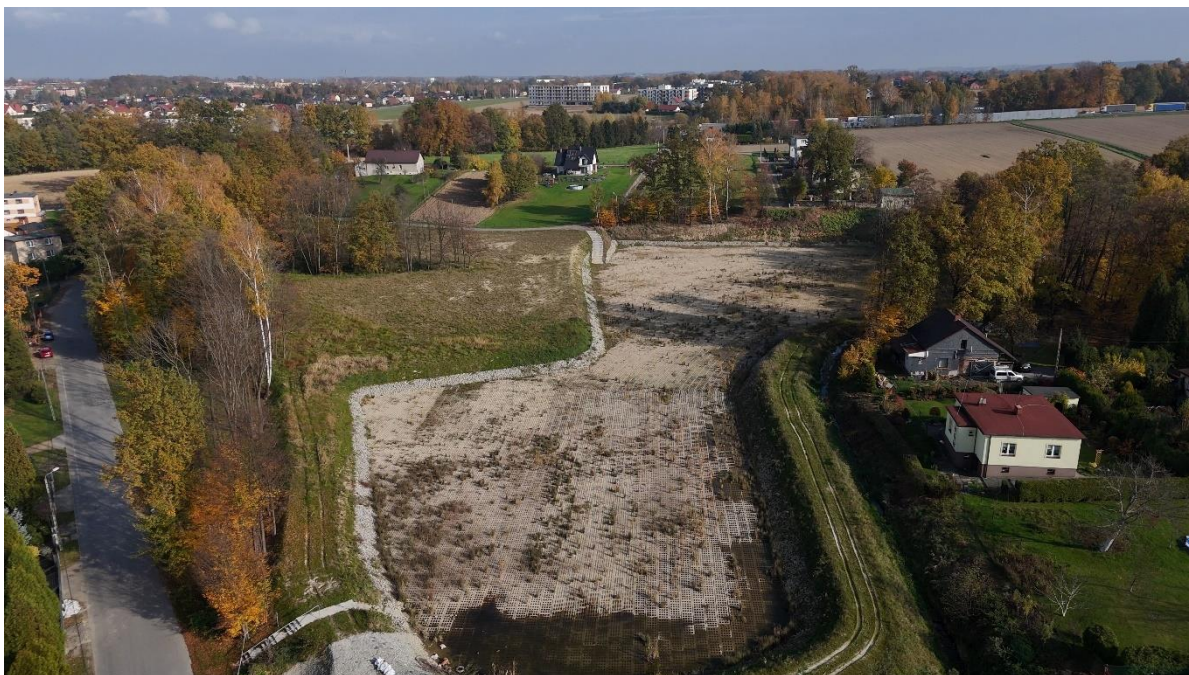
Fot. Zbiornik ul. Wodna/Brzeziny
