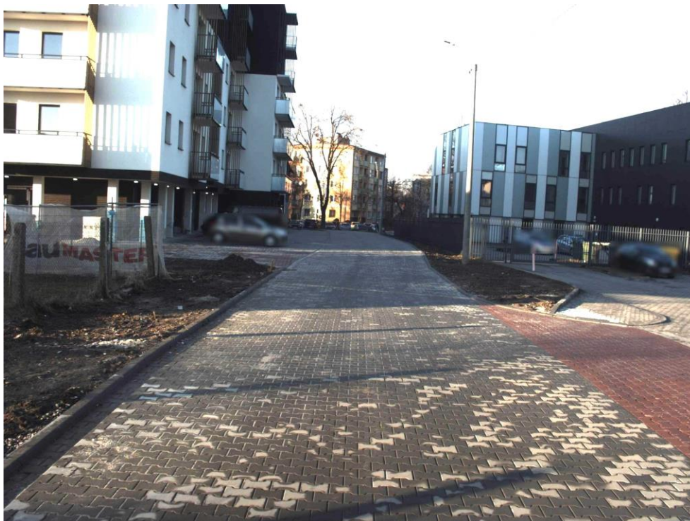
Fot. Przebudowana ulica Wesoła w Czechowicach-Dziedzicach.
