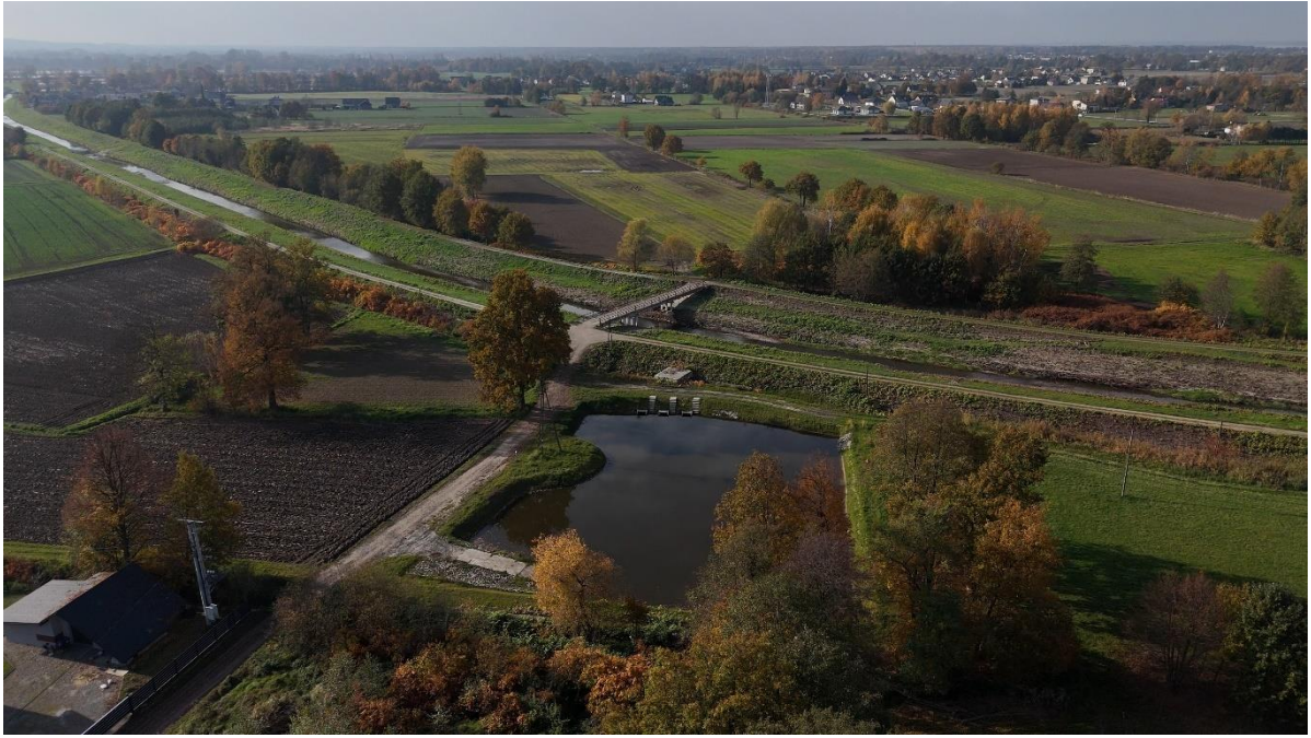
Fot. Zbiornik ul. Wodna (przy wale rz. Wapienica)
