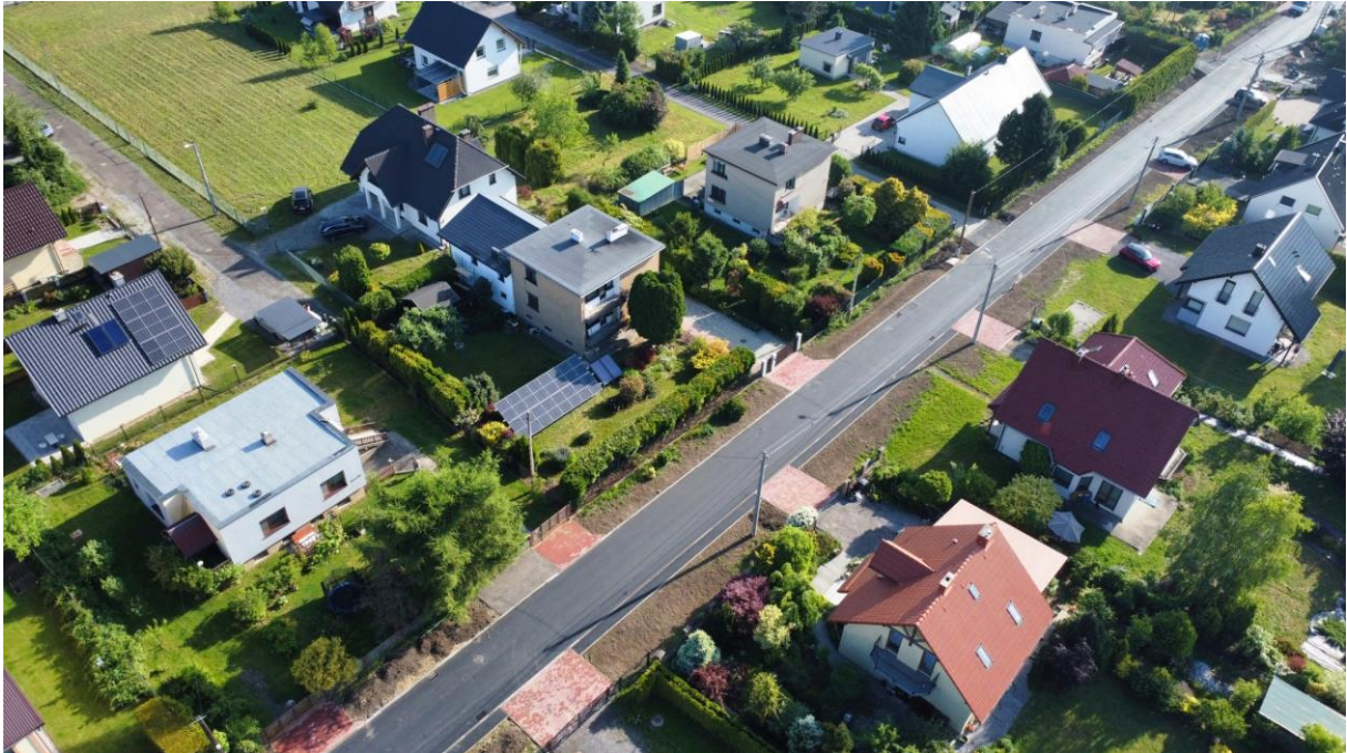
Fot. Przebudowana ulica Zawila w Czechowicach-Dziedzicach
