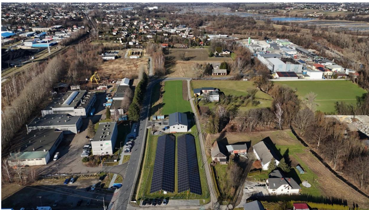
Fot. Przebudowana ulica Komorowicka w Czechowicach-Dziedzicach
