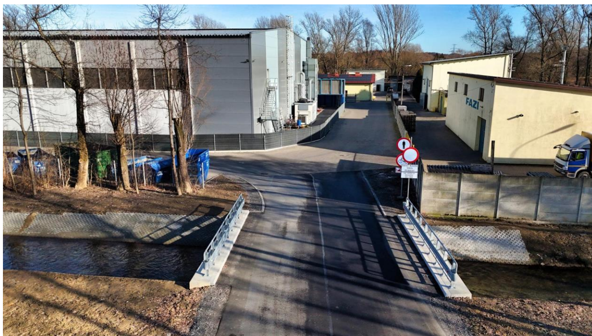
Fot. Zrealizowany przepust na cieku Młynówka Komorowicko-Czechowicka.
