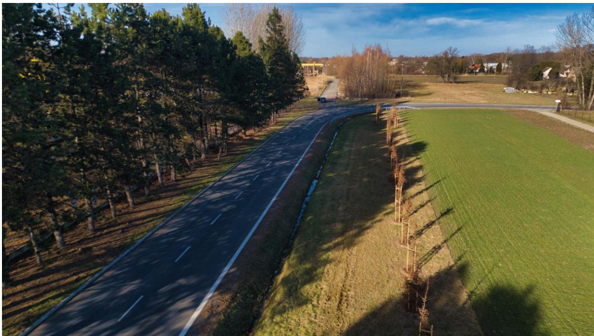
Fot. Przebudowana ulica Komorowicka w Czechowicach-Dziedzicach
