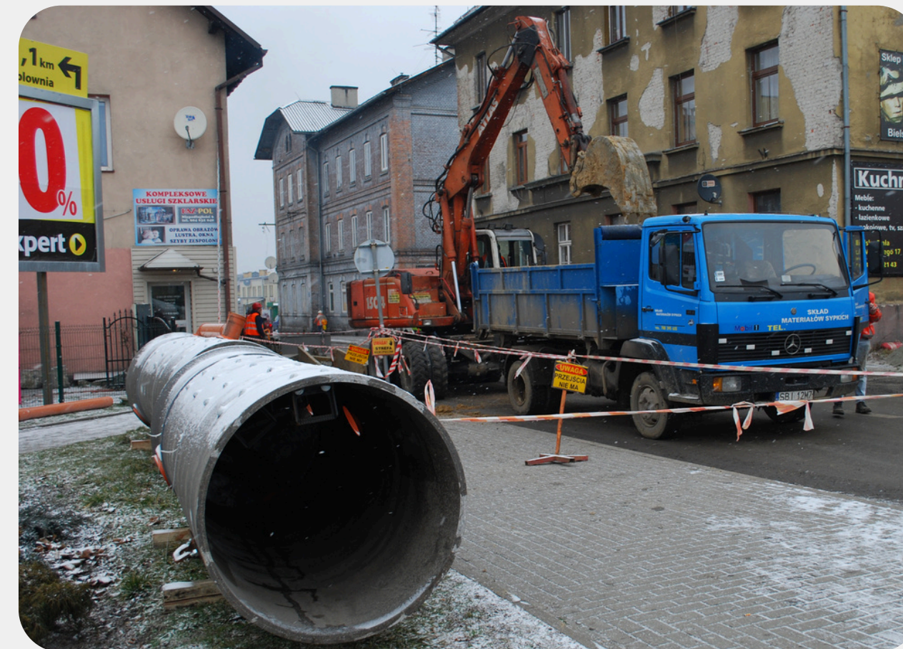
budowa kanalizacji w centrum miasta
