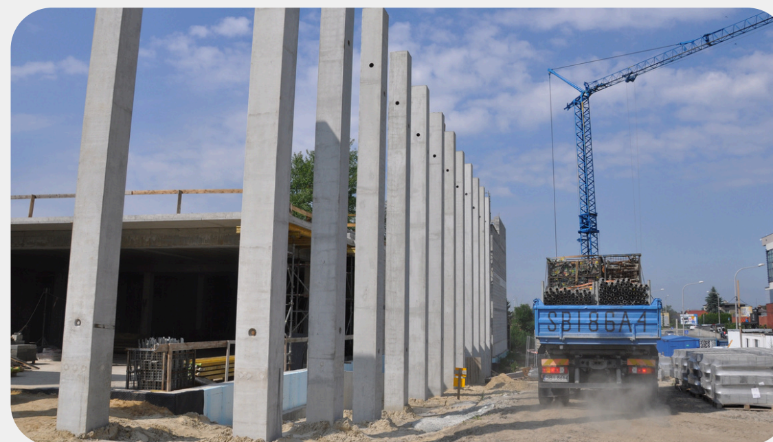
budowa nowej księżnicy
