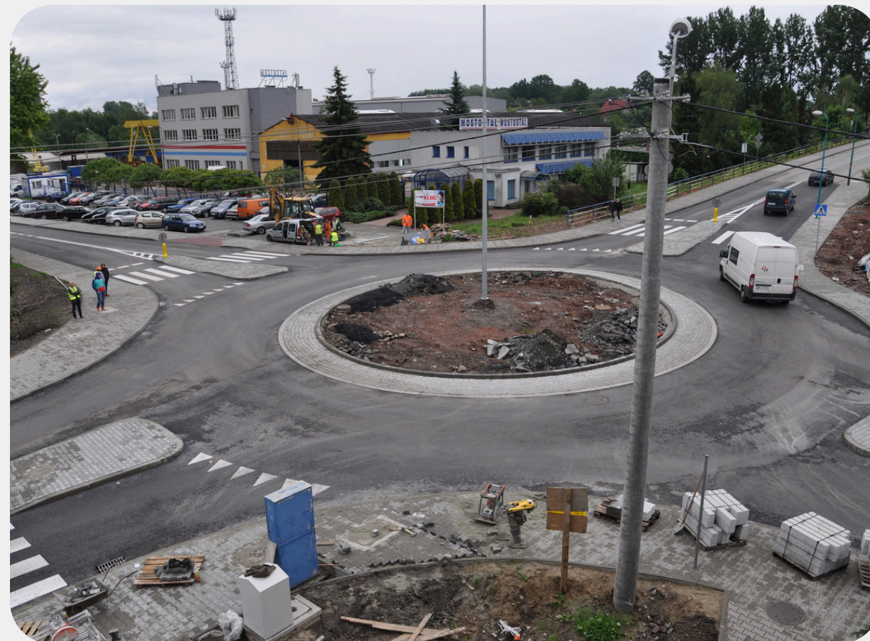
budowa ronda u zbiegu ul. Traugutta/Narutowicza/Drzymały
