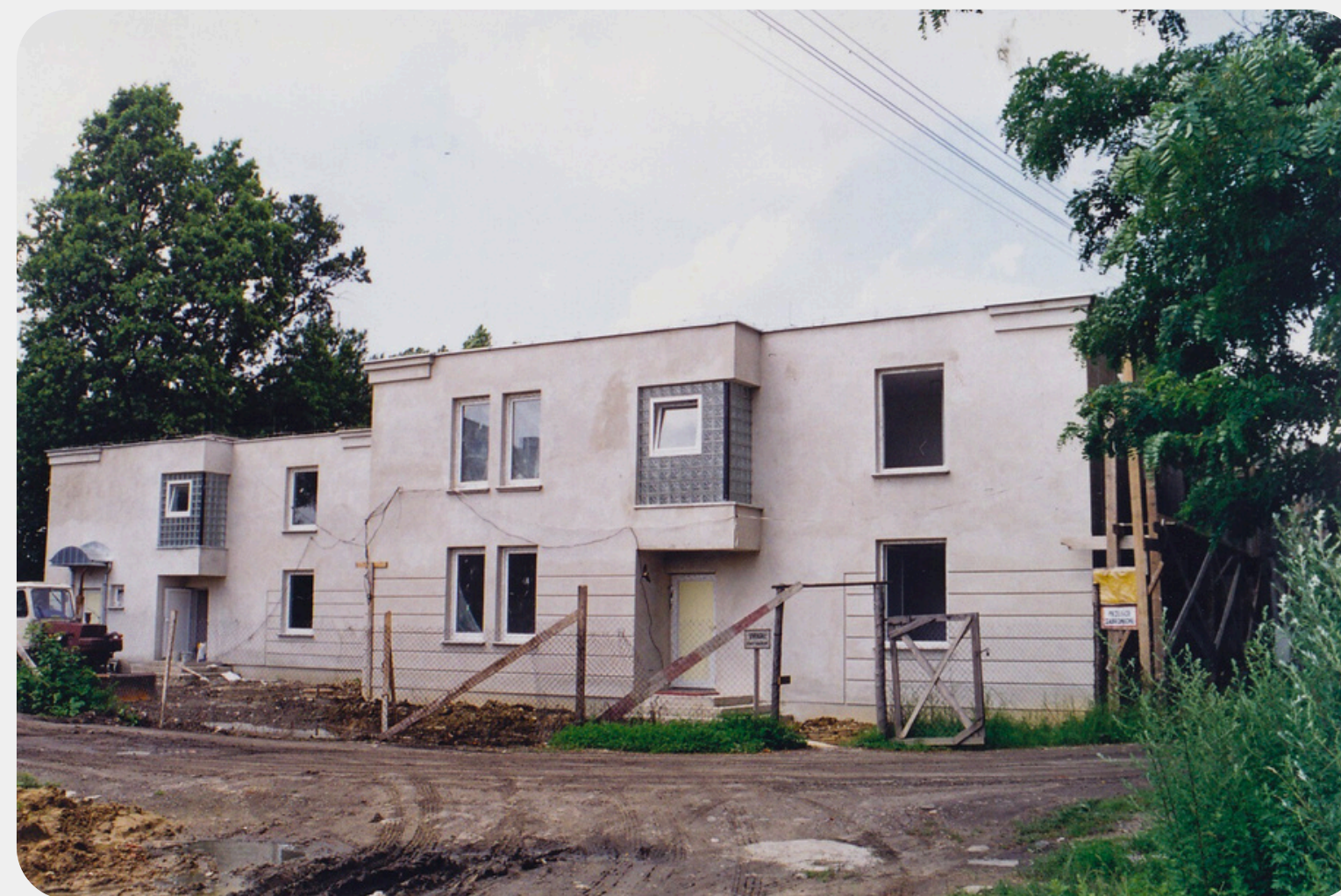
pierwszy budynek socjalny przy ul. Piasta
