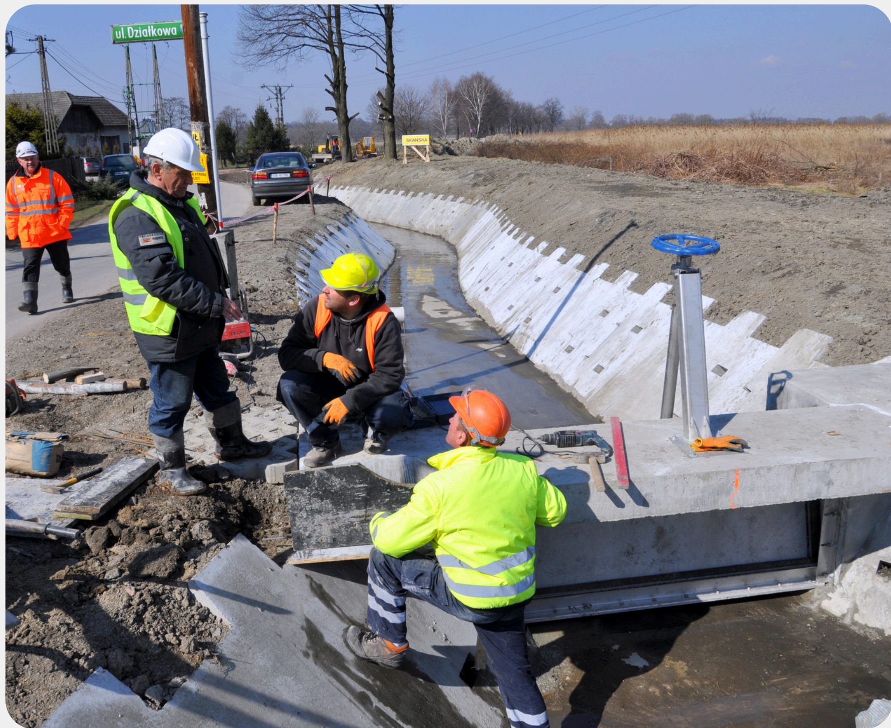
budowa kanału ulgi przy ul. Jasnej
