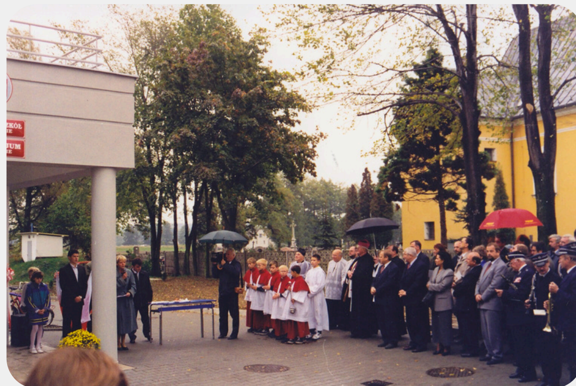
Szkoła Podstawowa w Ligocie po rozbudowie
