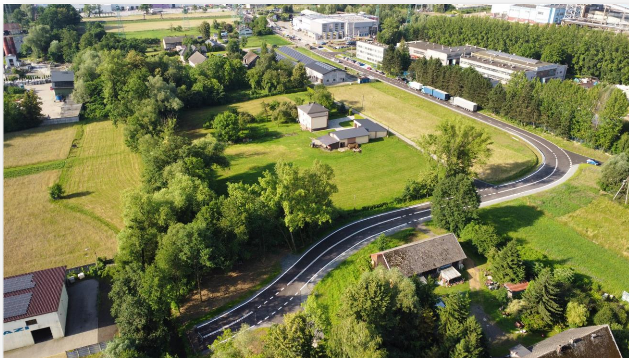
Przebudowana ulica Komorowicka - czerwiec 2024 r.
