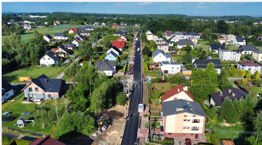
Przebudowa ul. Zawitej realizowana przy dofinansowaniu z Rządowego Funduszu Polski Ład
