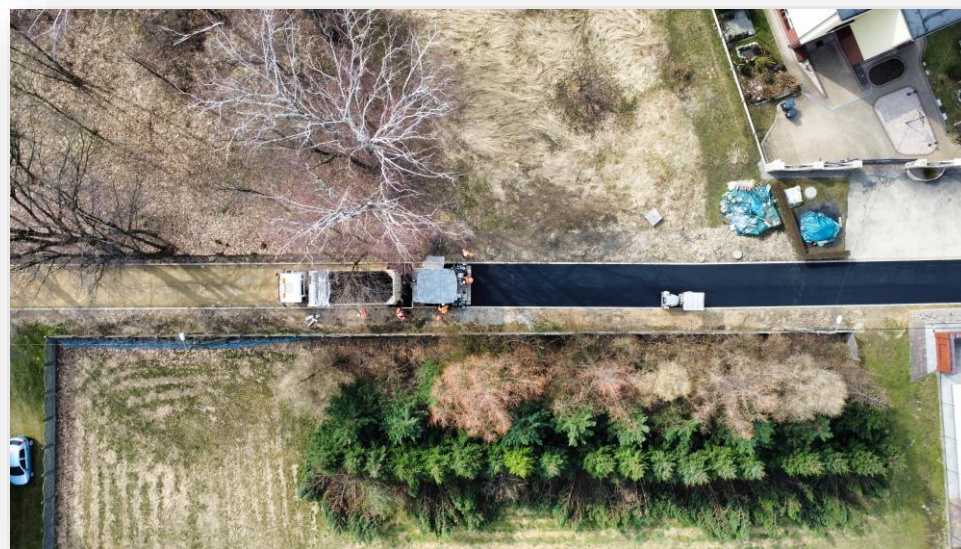
Asfaltowanie ulicy Pawiej - marzec 2023 r.
